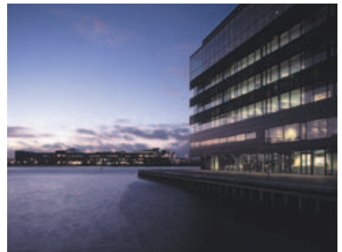
AI-gruppen har stået bag det første miljø certificerede kontordomicil i København. LO's hovedsæde i Havnestaden er som det første byggeri blevet præmieret både for sin arkitektur og sine ingeniørtekniske løsninger
