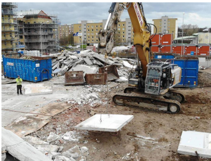
Foto: betonelement på Drottninghög
